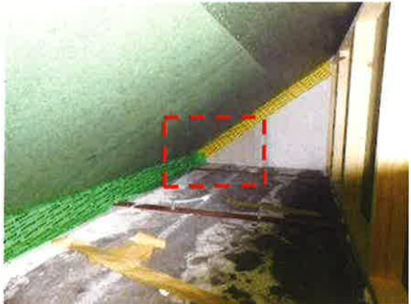
1-2 luchtdichting tussen dakelement en bouwmuur / muurplaat
