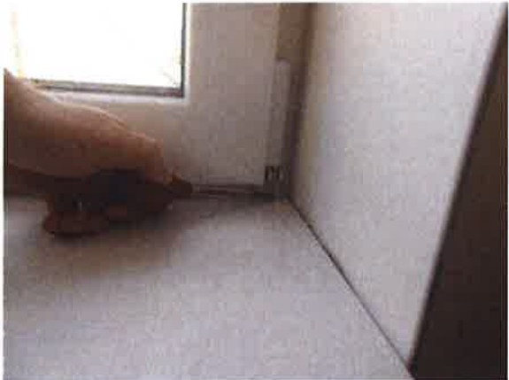
1 luchtdichting rondom het kozijn
