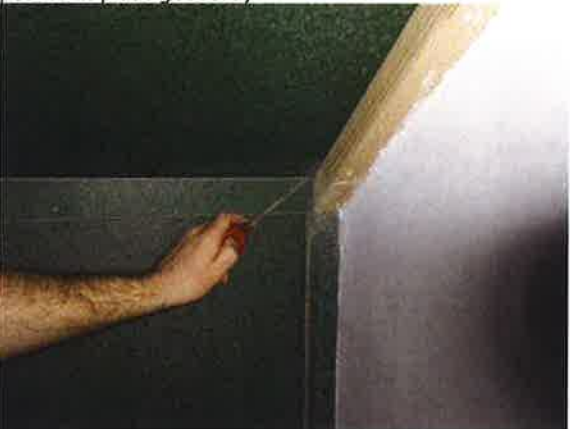
1 luchtdichting tussen dakelement en bouwmuur
