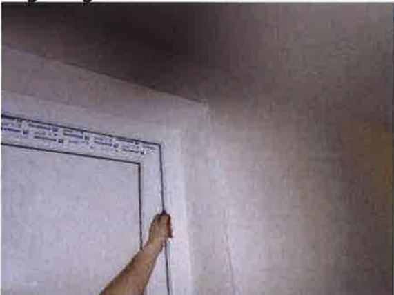
1 kierdichting bergingsdeur
