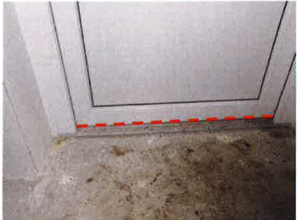
1-2 kierdichting bergingsdeur
