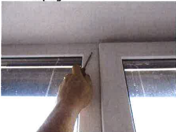
1 kierdichting raamkozijn
