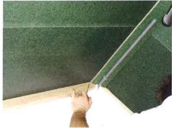
1-2 luchtdichting t.p.v. nok / kopgevel
