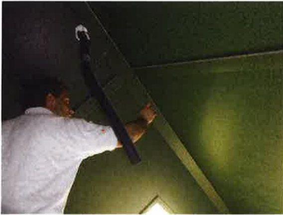
1 luchtdichting t.p.v. de nok
