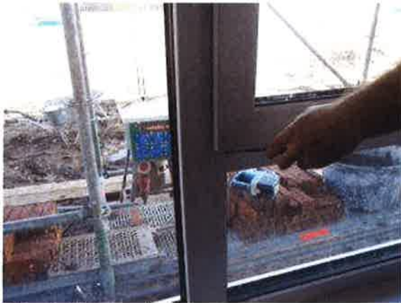
1 kierdichting raamkozijn
